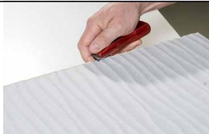
Kante abschließend mit Schleifschwamm (Körnung ca. 100) nacharbeiten. Dabei in Strukturaufrichtung über die Kante schleifen.
